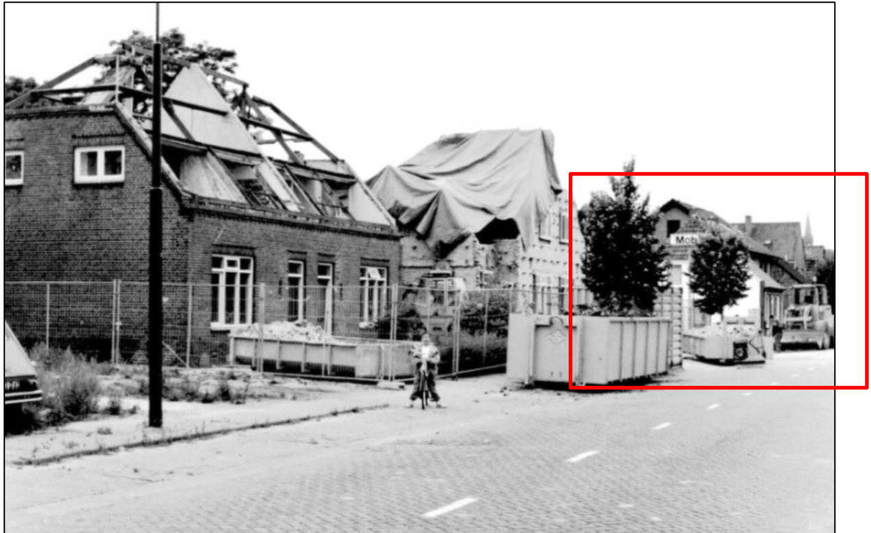
Figuur 5. Foto uit 1991/1992. Omkaderd de voormalige bedrijfswoning
