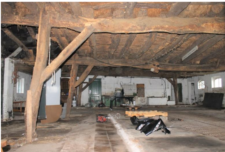
Drie ankerbalkgebinten richting de brandmuur
