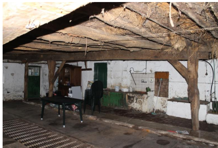
Linkergedeelte van de brandmuur
