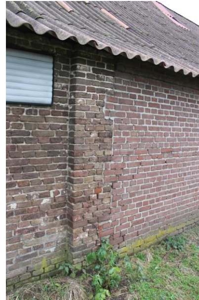
De aanheling het metselwerk
