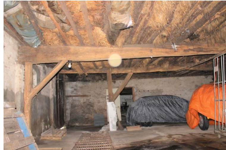
Gebinten in achterste ruimte waarbij gebintstijl van middelste ankerbalkgebint tegen de buitenmuur is geplaatst
