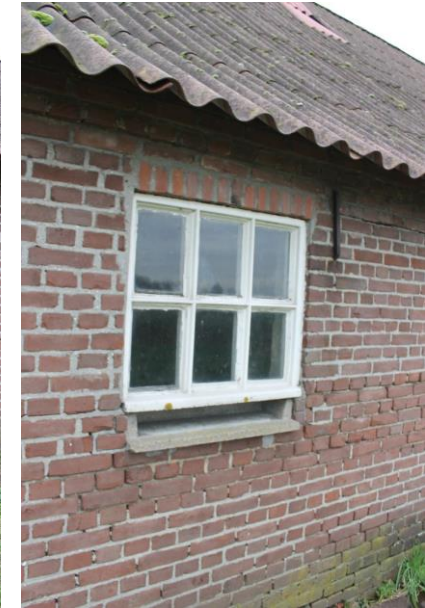
Inboetwerk in jaren '70 gevel boven het venster
