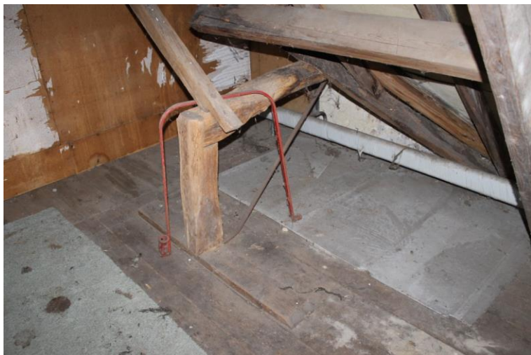
Onderdeel buitenzijde hallenhuis
