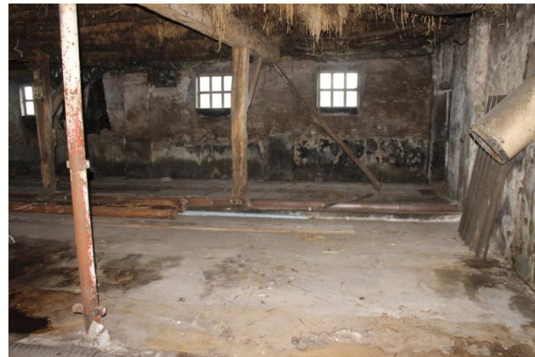
Aangepaste gebintstijl in achterste gedeelte
