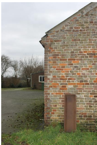
Aansluiting rechterzijgevel met achtergevel
