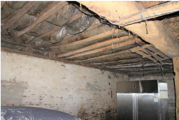
Scheidingsmuur vanuit de achterste ruimte
