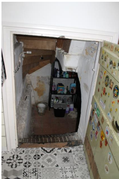
Toegang tot kelder met gemetselde trap
