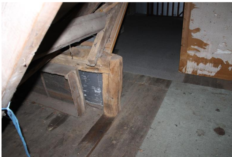
Onderdeel buitenzijde hallenhuis
