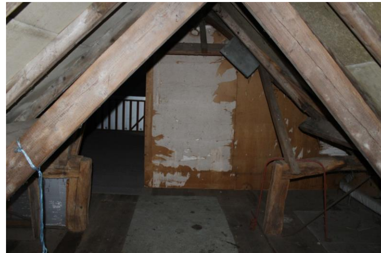
Gezaagde kapconstructie van het krukhuis en aansluiting van hallenhuisconstructie
