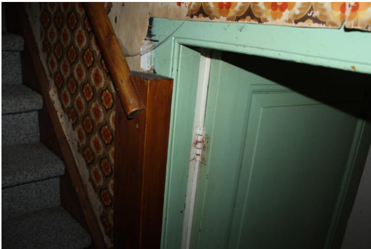
Kozijn en deur van de trapopgang
