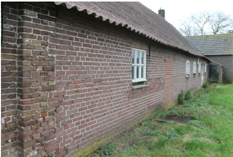
Het metselwerk van het overige deel van de linkerzijgevel, vermoedelijk uit de jaren '70 van de 20 ste eeuw
