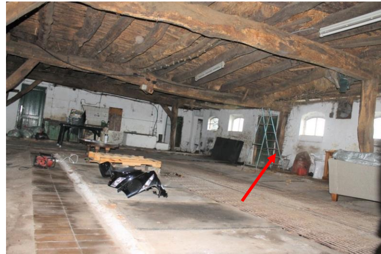
Drie ankerbalkgebinten waarbij bij het middelste gebint de gebintstijl tegen de buitenmuur is geplaatst
