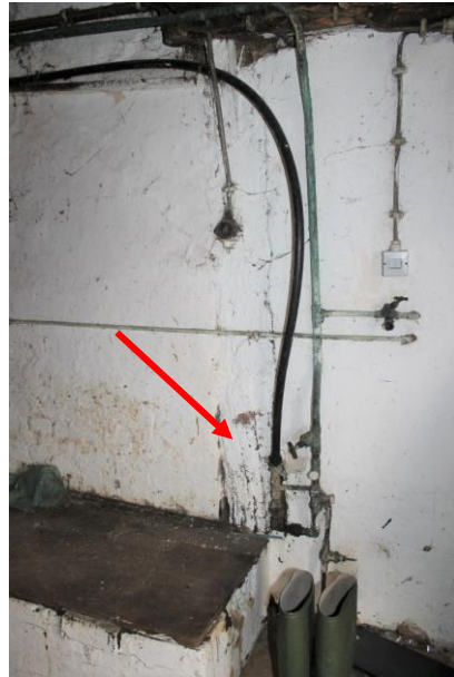
Gebintconstructie in de brandmuur
