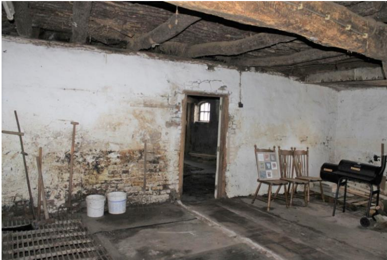
Scheidingsmuur tussen twee bedrijfs gedeelten
