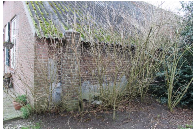
Zijgevel van het krukhuis met aansluiting nieuwe voorgevel
