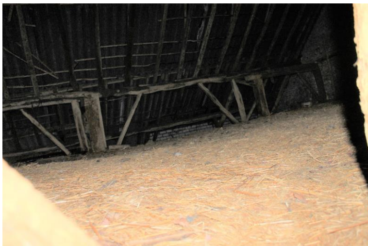
Eerste en tweede gebintstijlen met hulpconstructie
