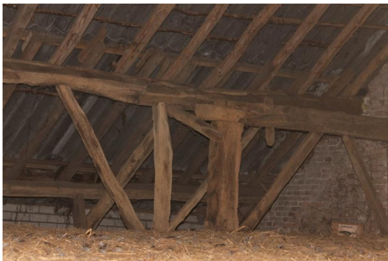
Eerste gebintstijl op zolder met hulpconstructie
