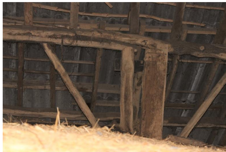
Derde gebintstijl met hulpconstructie
