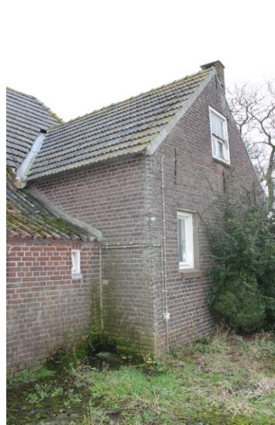
Achter- en kopgevel krukhuis
