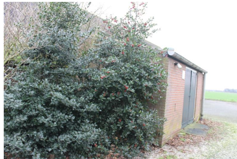
Later aangebouwde melkruimte
