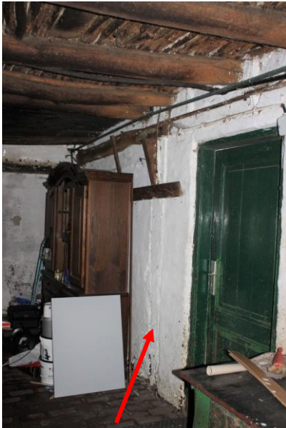
Paneel deur in brandmuur van bedrijfs gedeelte naar woongedeelte met links gebintconstructie
