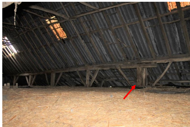
Overige gebintstijlen met rechts de derde gebintstijl met hulpconstructie
