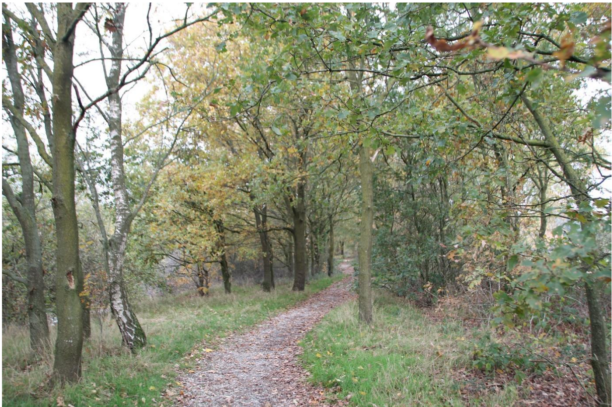
Foto: de paden hebben een ondergrond van leem en een toplaag van fijn grind. Ze blijven voldoende breed en vrij van onkruid.
