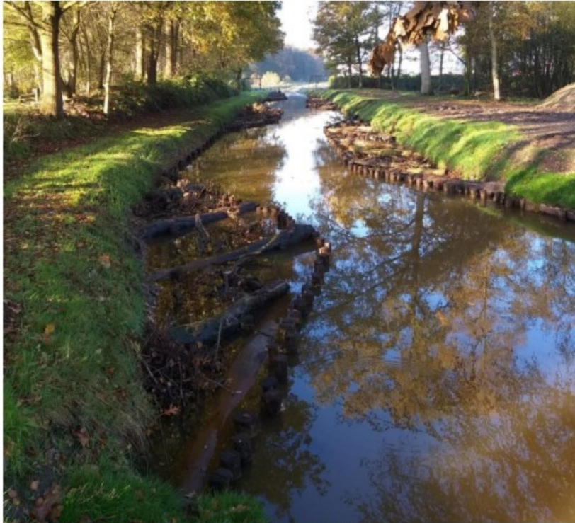
Figuur 13: Doodhoutpakketten in watergang
