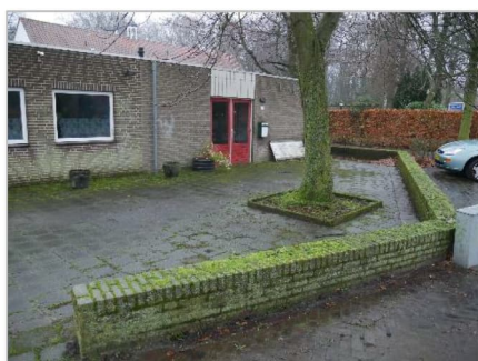
Foto 4: Plangebied (plaatsje bij opstal).
