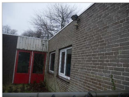
Foto 16: Plangebied (dakstudie en betimmering boven ingang opstal).
