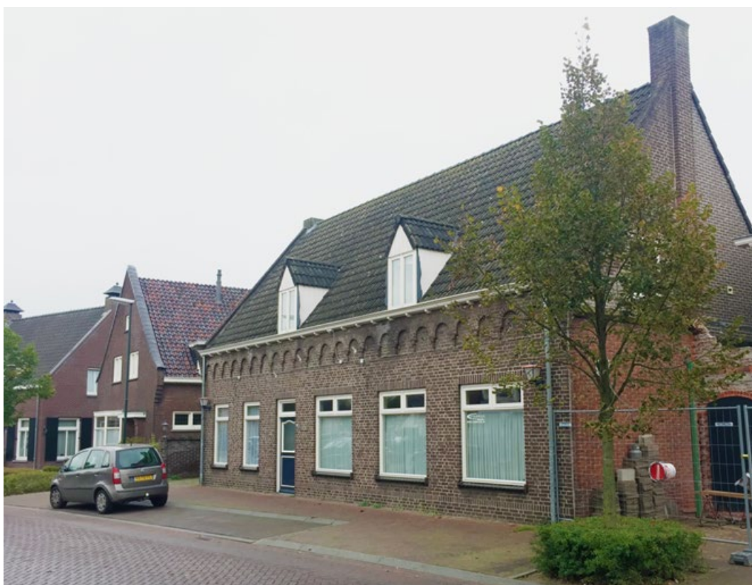
Aanzicht van de voorgevel van het bestaande pand (bron: eigen werk)
