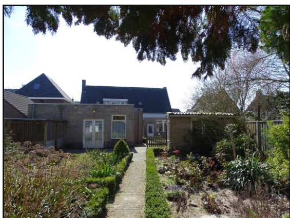
Fig 8. De bebouwing en tuin in het plangebied, vanuit noord.
