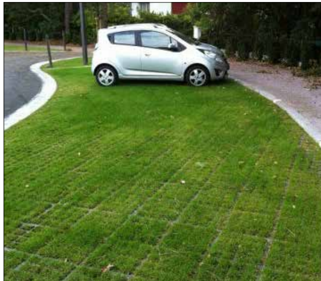
Referenti parkeerbakken in gestabiliseerd gras
