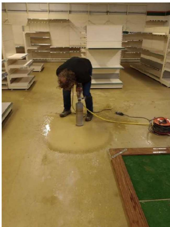
Figuur 10. Betonboring.
