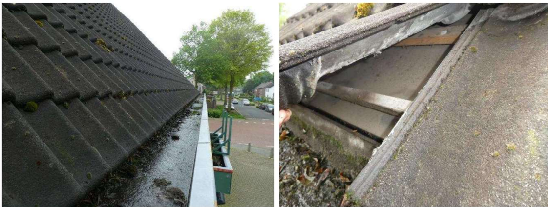
Afbeelding 7 en 8: Geen nesten van de huismus aangetroffen in de te slopen bebouwing. Bron: BNL advies. Datum: 11-06-2023
