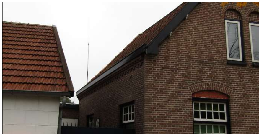
Figuur: ook de twee woningen die daar aan het te slopen gebouw grenzen, beschikken over dit soort dakpannen.
