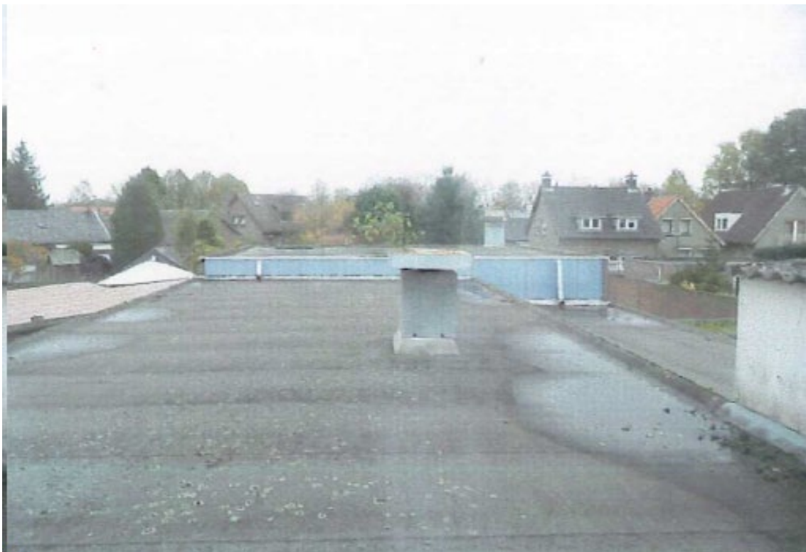
Figuur 2.3 Aanzicht vanaf achterzijde projectgebied / dak van de danszaal
