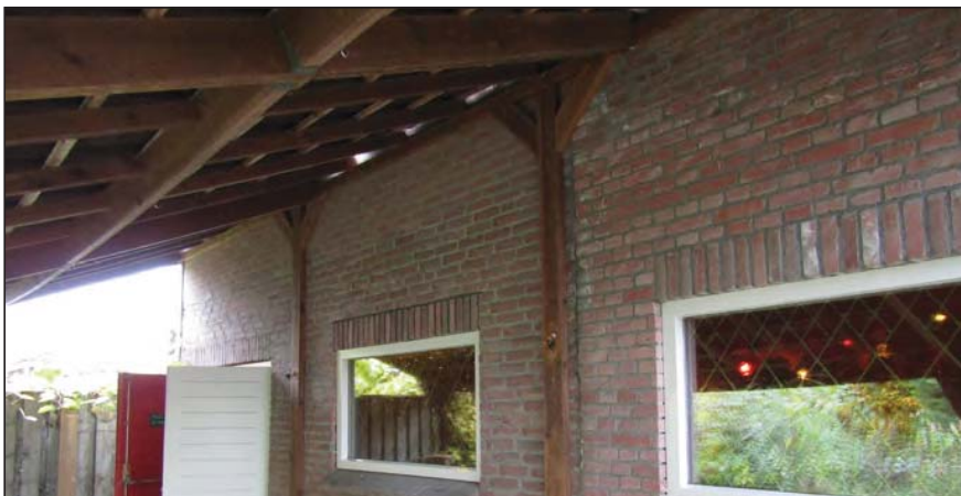
Figuur: het gebouw bevat geen open stootvoegen waardoor vleermuizen de spouw niet kunnen bereiken.
