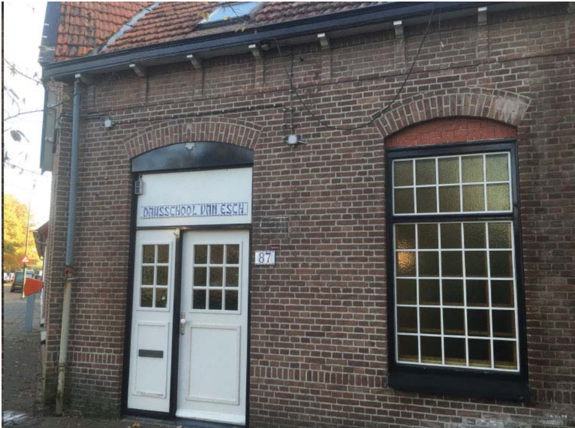
Figuur 2.4 Bestaande entree
