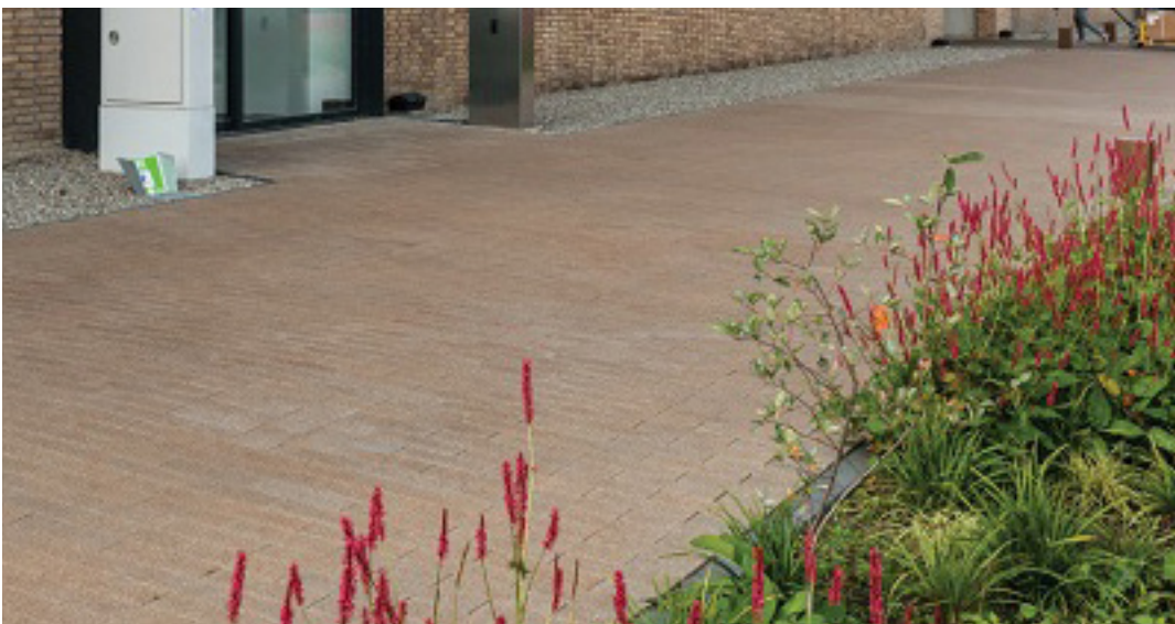
Betonsteen in waalformaat voor het voetpad
