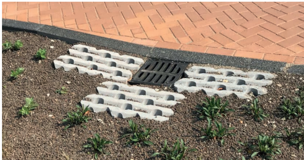
Afwatering met grasbetonstenen en verlaagde trottoirband
