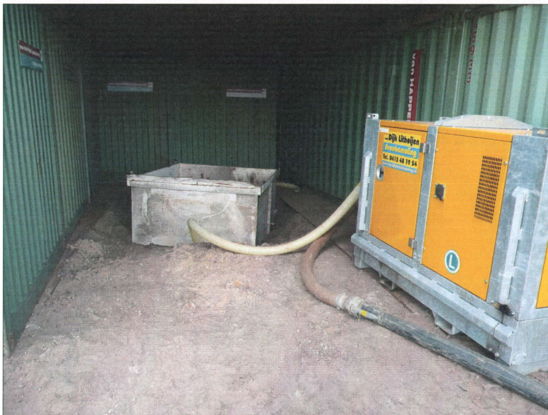
Foto 1: blik in de bomcontainerconstructie met bomschacht
