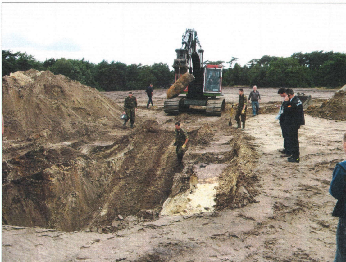
Foto 2: civieltechnische ondersteuning met Cat. II beveiligde graafmachine
