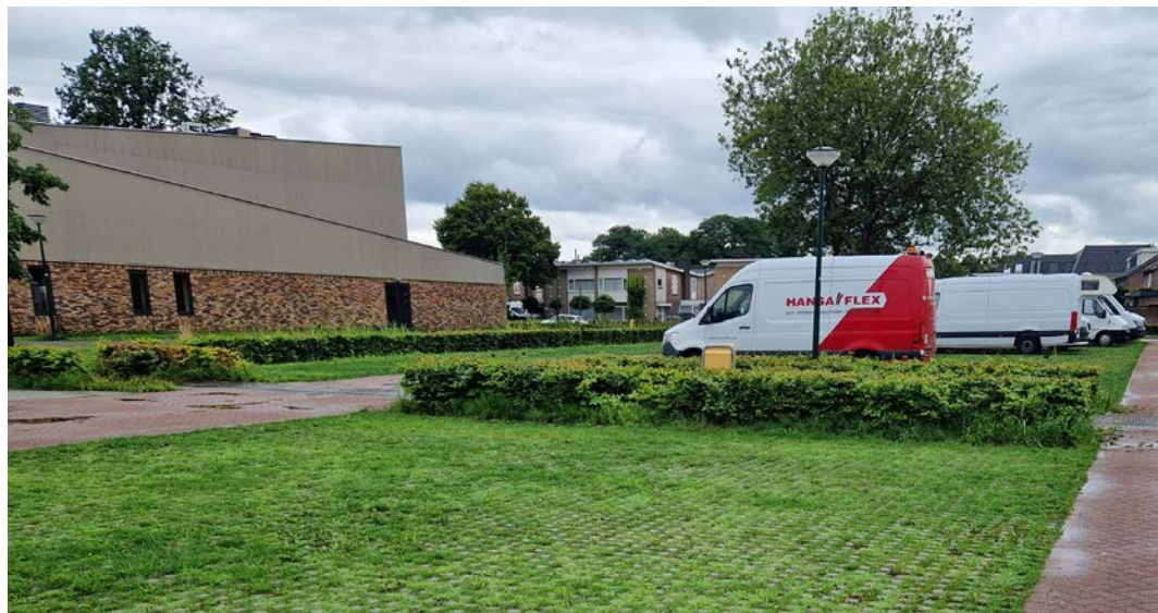
Parkeerhof met haagjes en grasbetonstenen
