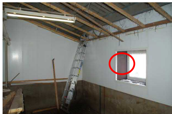
Binnen zijde varkensstal, brede spouwmuur met luchtinlaat
