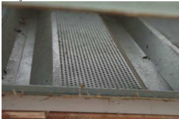
2x Luchtinlaat geperforeerde damwandprofielen
