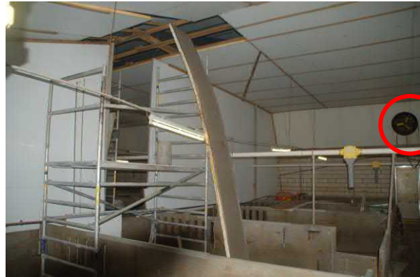
Binnenzijde varkensstal met rechts de ventilator naar de centrale afzuiging.
