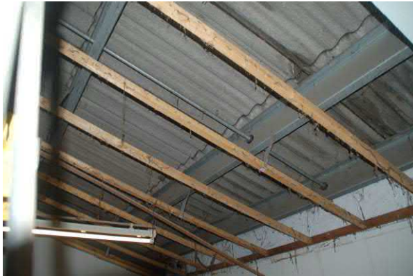
Golfplaten dak met stalen spanten.
