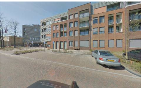
vier bouwlagen zonder dak
