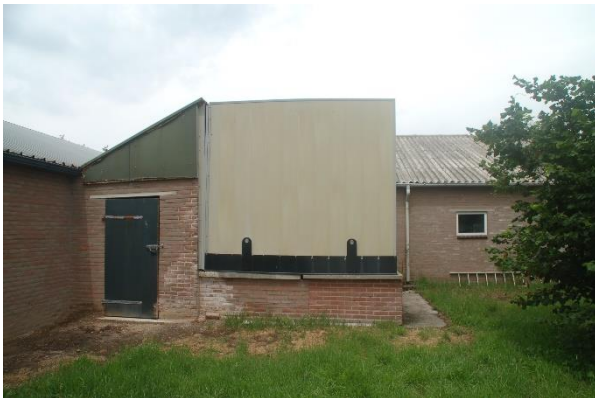
Afbeelding :luchtwasser
