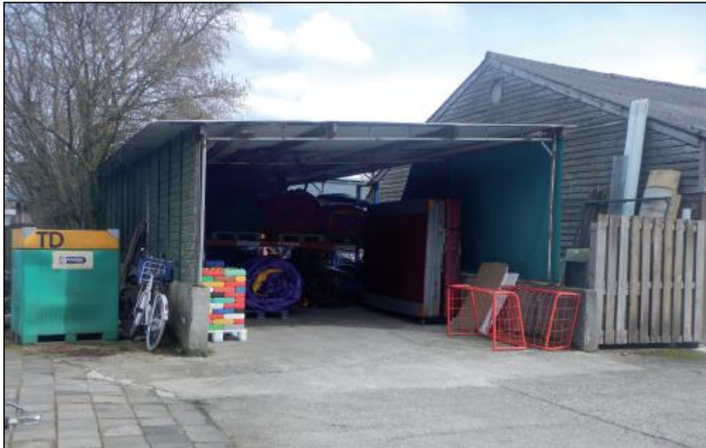
Figuur 4.2 Te slopen caravanstalling
