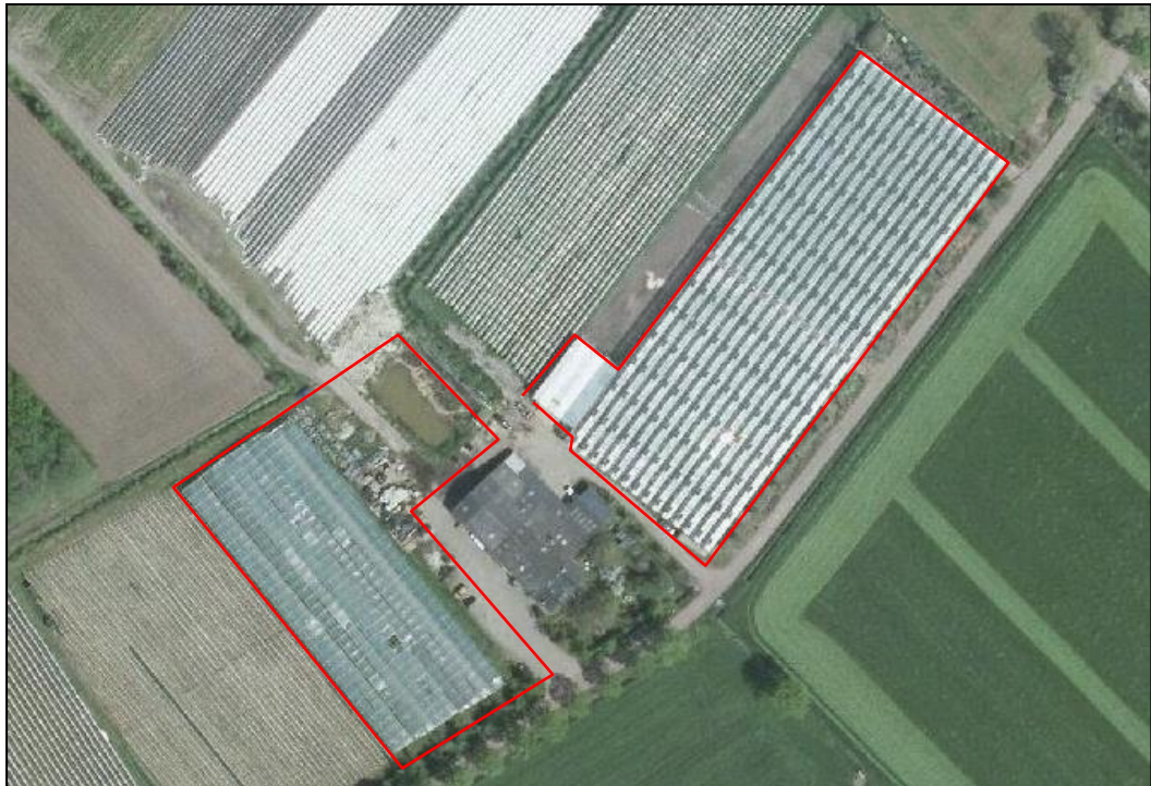
Figuur 3.5 Te slopen bebouwing en verharding
