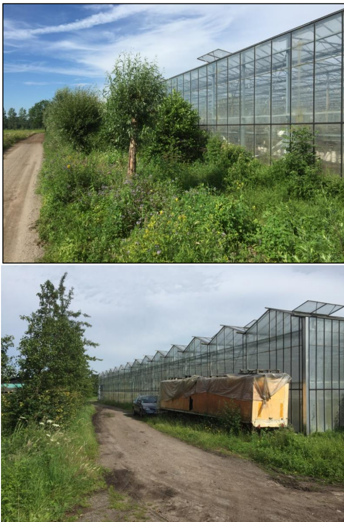
Figuur 3.4 De bestaande kassen, direct naast de Galgeveldseweg
