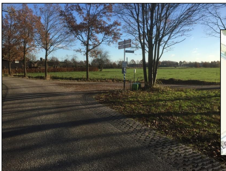
Figuur 4.12 Aansluiting Broekstraat-Galgeveldseweg: te krappe bocht
