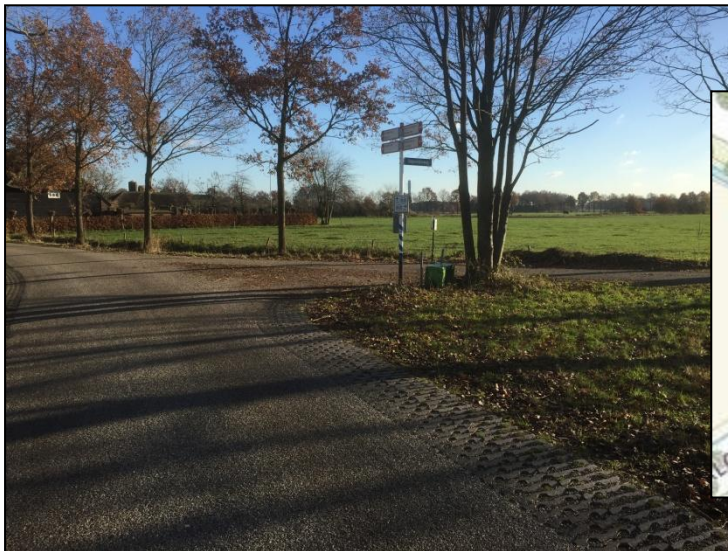
Figuur 4.12 Aansluiting Broekstraat-Galgeveldseweg: te krappe bocht
