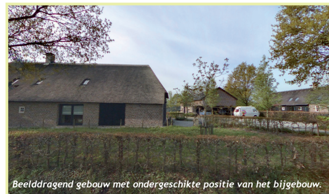
Bedrijfsbebouwing: sobere en doelmatige vormgeving en uitstraling.
