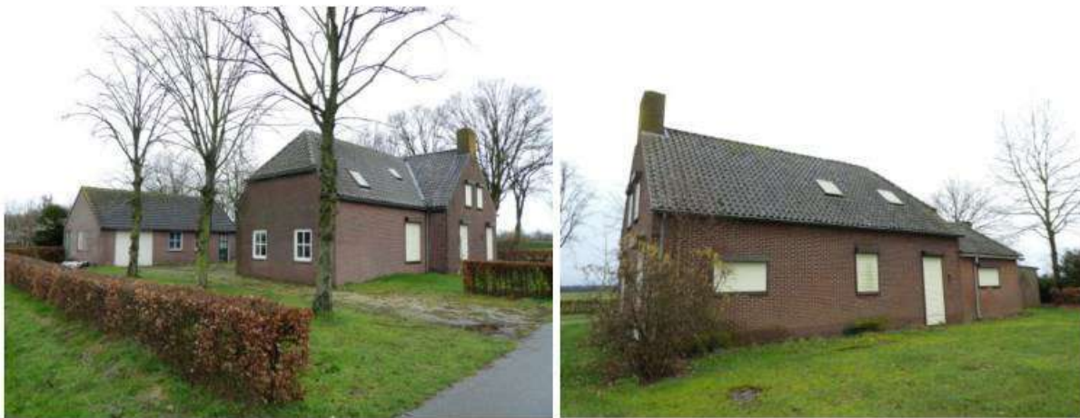
Afbeelding 3 en 4: Bestaande te slopen bebouwing. Bron: BNL advies. Datum: 23-03-2023
