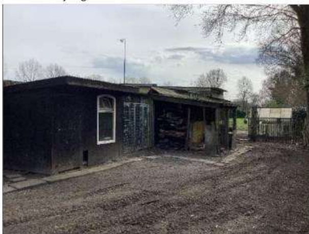
Foto 11 Foto van de westzijde van de bebouwing
