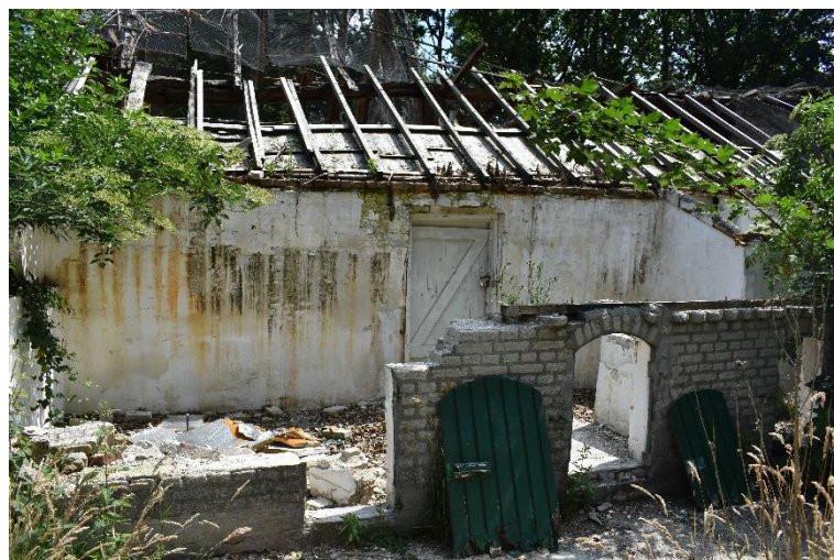
Varkensstal uit ca. 1930 tegen de achtergevel.
