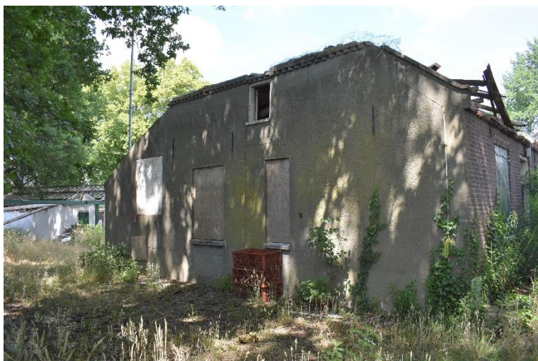
Linkerzijgevel met cementering.
