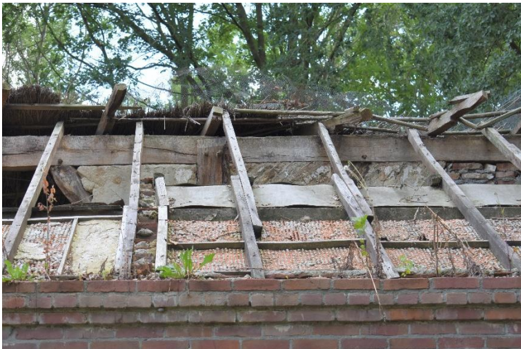
Stroomlaag in het metselwerk tussen het langsgebint.
