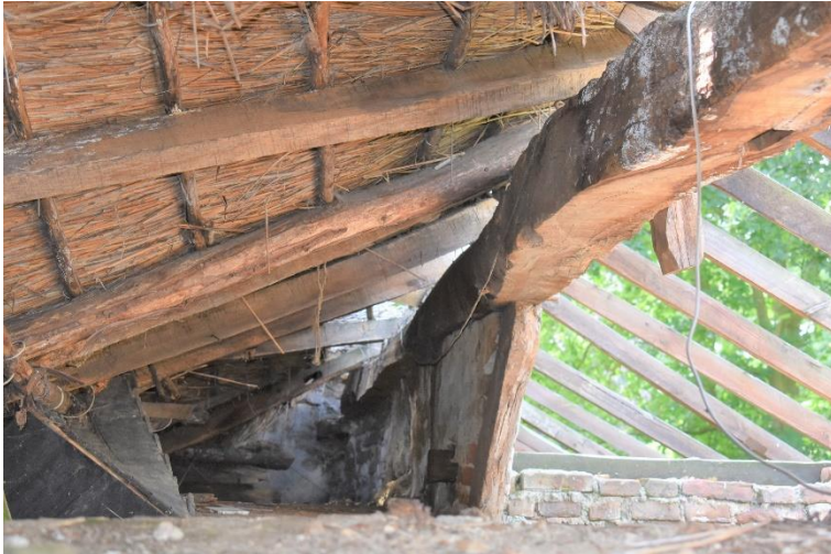
Langsgebint ter hoogte van de opkamer is opgevuld met metselwerk.
