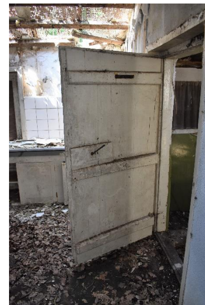
Opgeklampte deur tussen keuken en voorstal.
