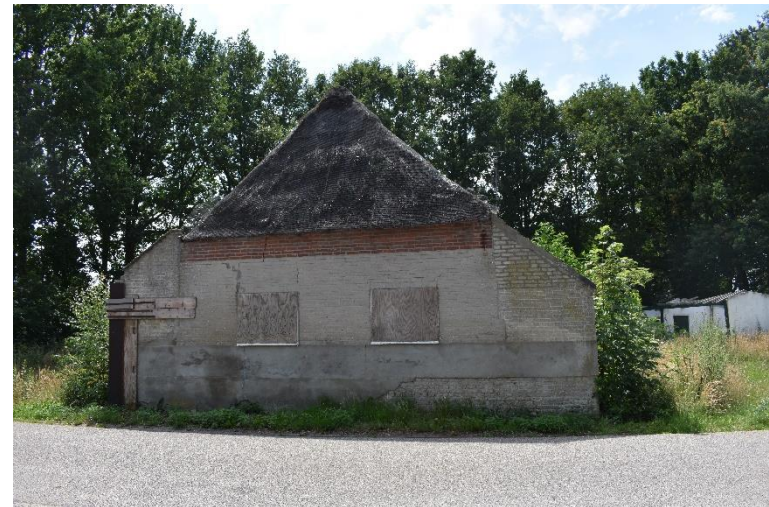
Rechterzijgevel opgetrokken in cementsteen in ca. 1930.
