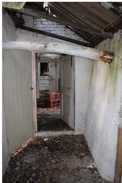
Gang langs de achtergevel in het Bedrijfsgedeelte.
