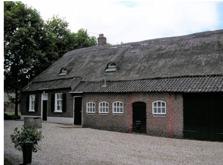
De voorgevel enkele jaren geleden. Tussen de rode lijnen bevond zich oorspronkelijk de potstaldeur. Bron: gemeente Gemert-Bakel.
