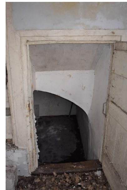
Toegang tot de kelder.
