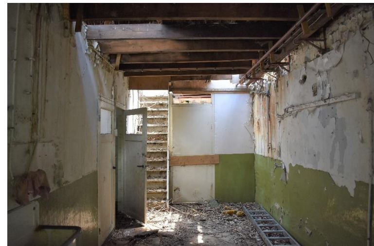
Voorstal met links de deuren naar toilet en badkamer.
