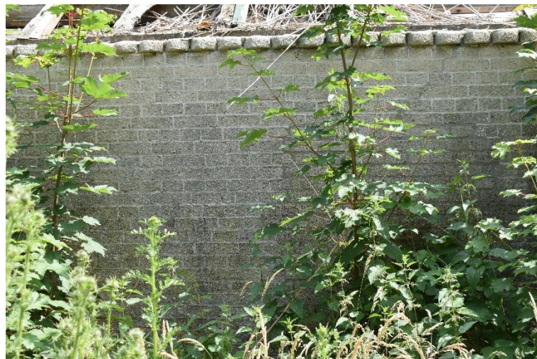
Metselwerk van cementsteen uit ca. 1930 in achtergevel.
