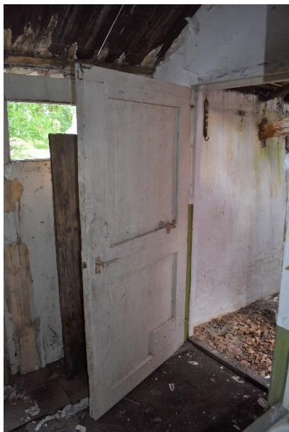
Deur richting de gang langs de achtergevel.
