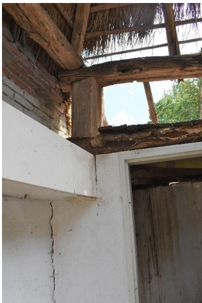
Afgetimmerde gebintstijl in het bedrijfsgedeelte.
