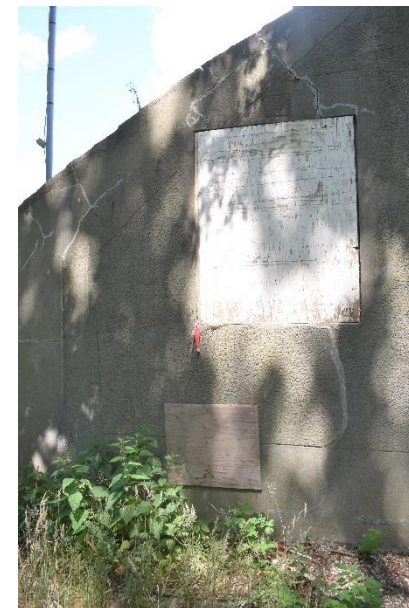
Opkamer- en keldervenster in Linkerzijgevel.
