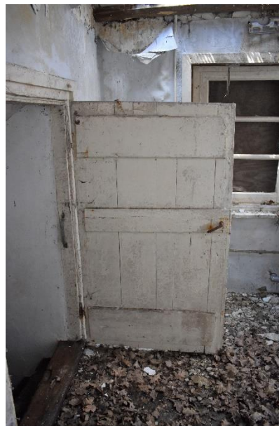
Opgeklampte deur tot de kelder.
