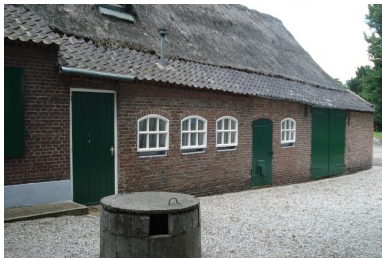
Voorgevel van het bedrijfsgedeelte enkele jaren geleden. De waterput is inmiddels verdwenen. Bron: Gemeente Gemert-Bakel.
