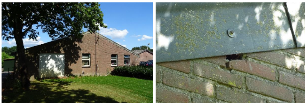
Afbeelding 11, 12 en 13: Aanwezige kantine/ garage met openingen in de kopse kant van de muur welke mogelijk toegang bieden tot de achterliggende spouw. Bron: Datum: 21-07-2020
