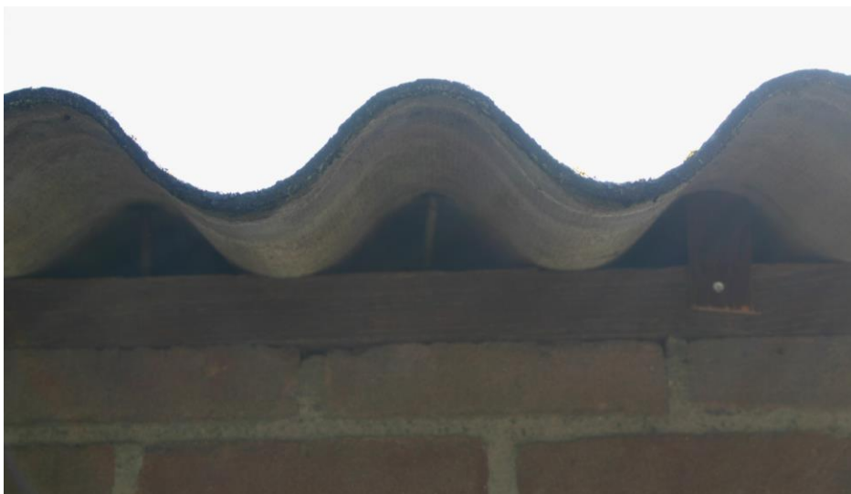
Figuur 4.2.4. Onder het golfplaten dak van de varkensstallen is plaats voor huismusnesten, maar niet voor steenuilen.
