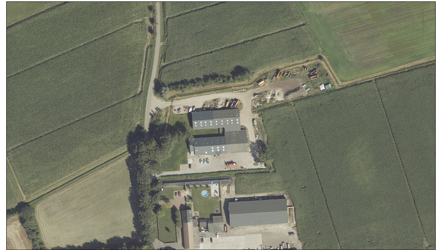
Luchtfoto bestaande situatie (2019)
