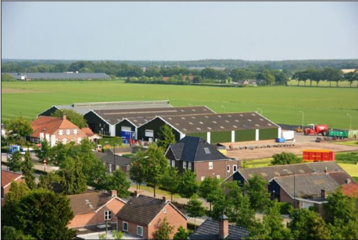
Figuur 3 Zicht op de locatie
