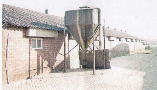
Foto 6. Golfplaten dak stal 2
