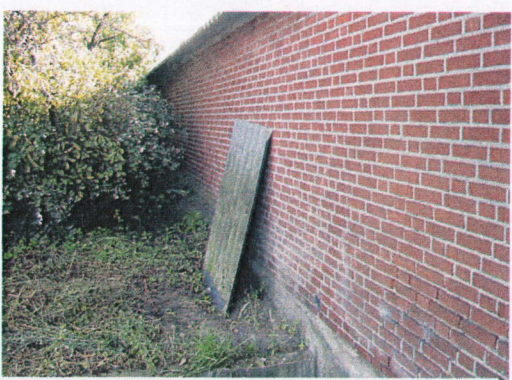
Foto 10. Zwerfasbest voorzijde stal 1
