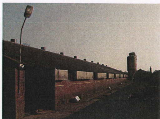
Foto 1. Golfplaten dak stal 1
