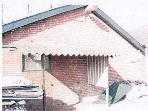
Foto 17. Golfplaten op afdak
