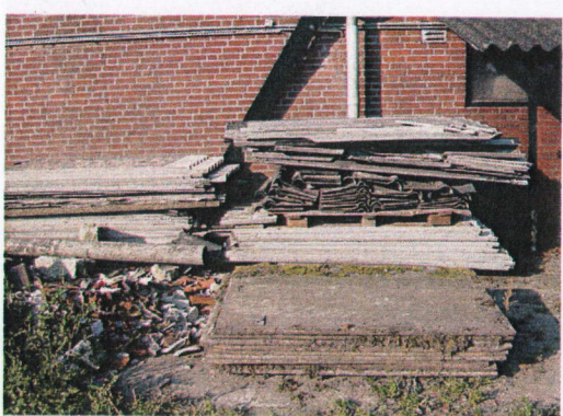
Foto 11. Zwerfasbest achterzijde stal 1
