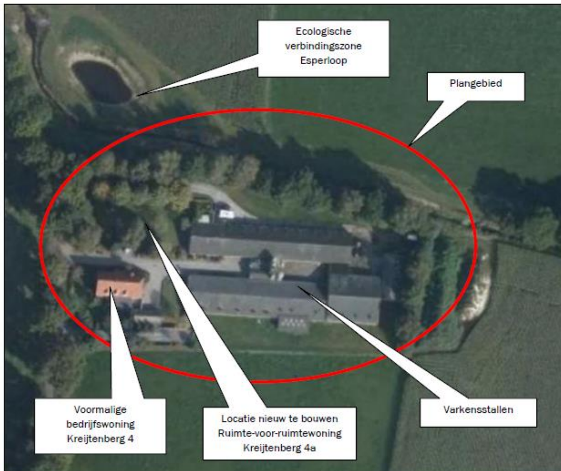
Figuur 3: Foto's bestaande situatie
