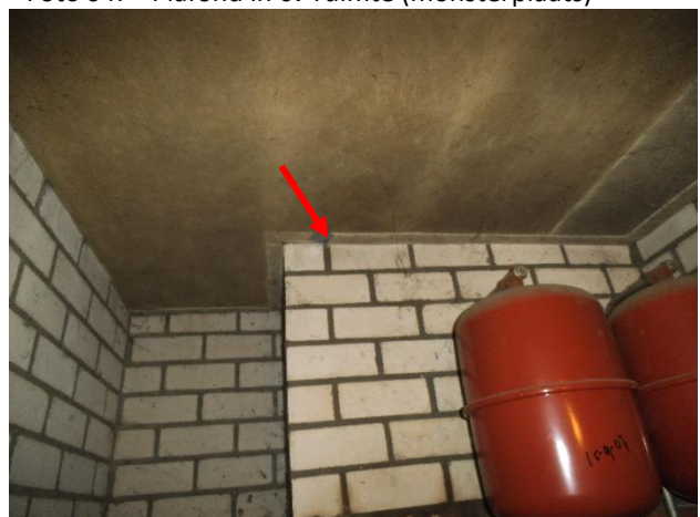
Foto 04: Plafond in cv-ruimte (monsterplaats)
