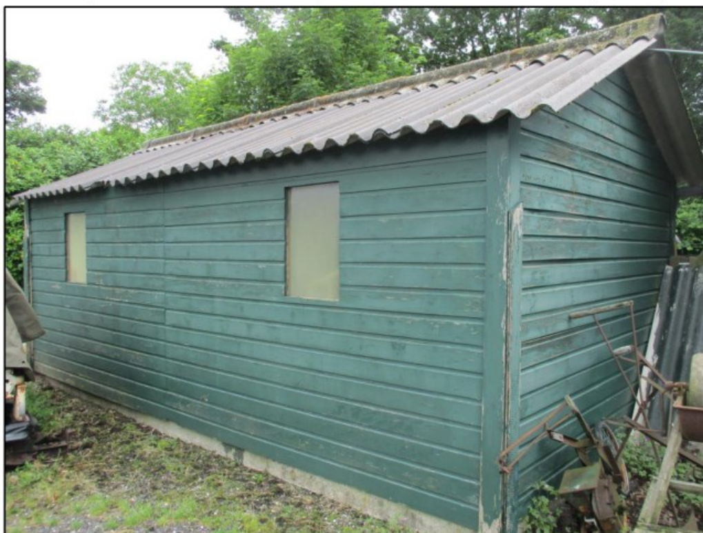
Figuur 2 Schuur B op de planlocatie bestaat uit een enkele houten muur met golfplaten, waarin geen dakbeschot aanwezig is.
