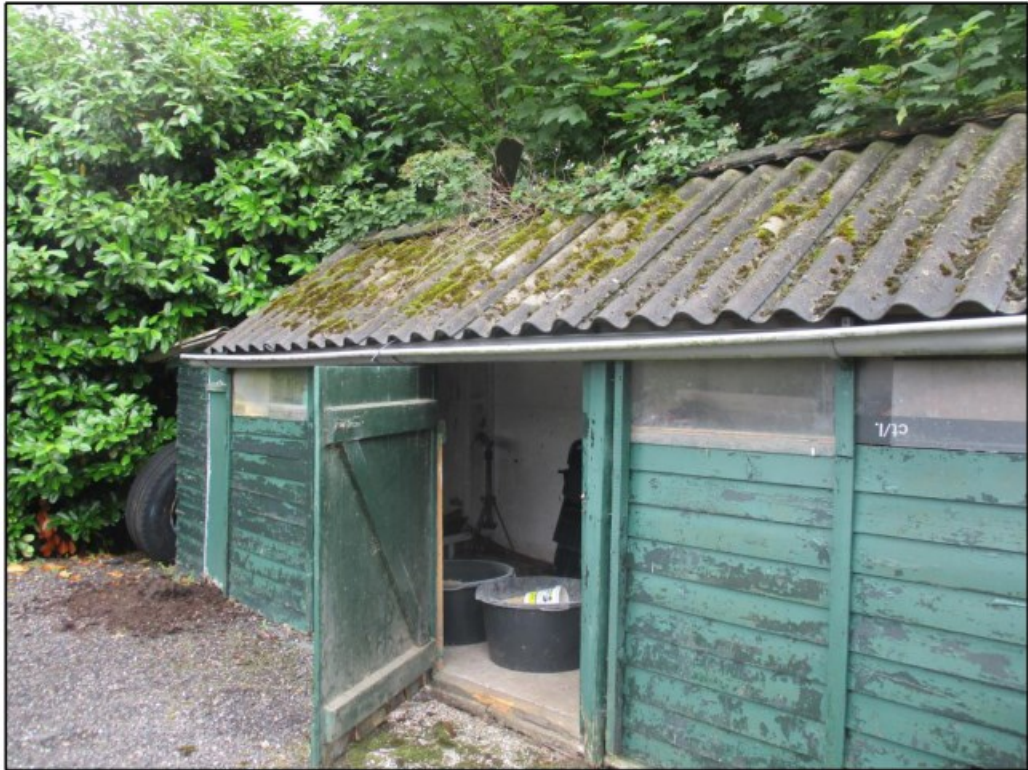
Figuur 3 Schuur C op de planlocatie. Deze schuur bestaat uit enkele houten platen met een golfplaten dak. Er is geen dakbeschot in deze schuur aanwezig
