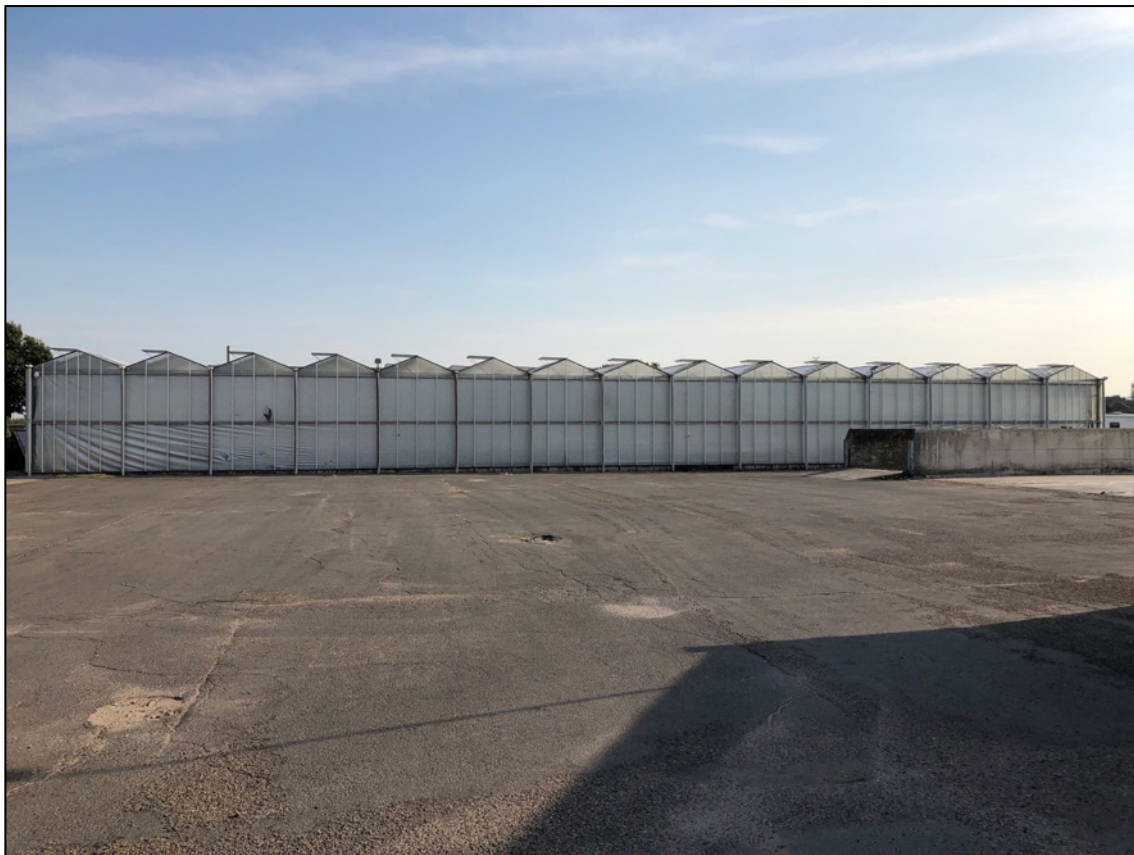
Figuur 2.3 Foto's planlocatie. Boven het (voormalig) kantoor en onder de tuinbouwkas
