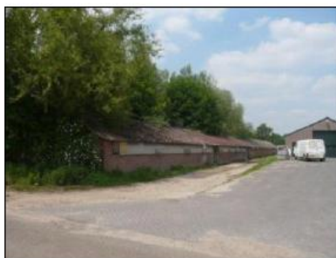
Bestaande varkensstal Breemhorstsedijk 4a
