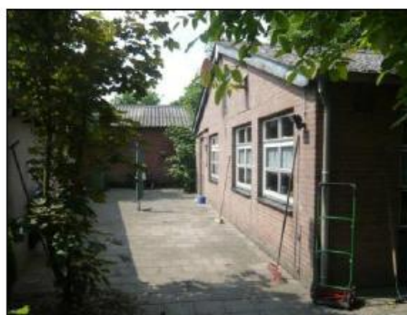
Woning in loods (overgangsrecht)
