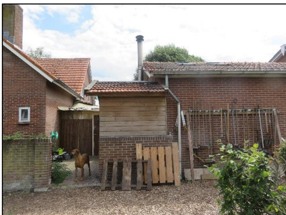
Foto 1. Locatie van het nieuwe bijgebouw (aanbouw)
