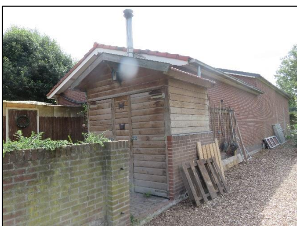
Foto 3. Locatie van het nieuwe bijgebouw (aanbouw)
