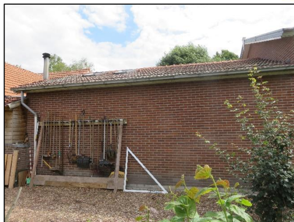
Foto 2. Locatie van het nieuwe bijgebouw (aanbouw)
