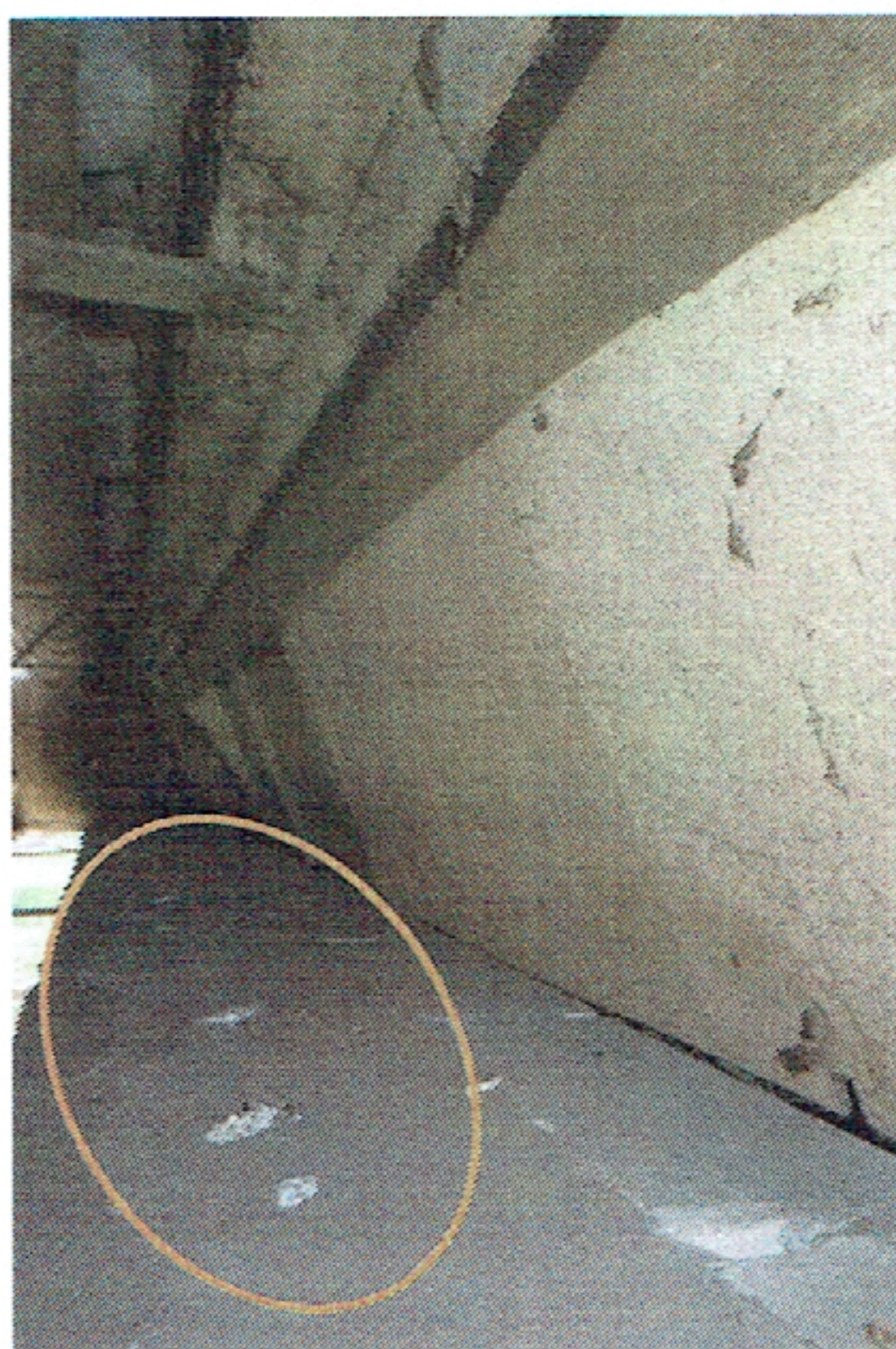
Afbeelding 4 & 5: Spouwmuur is vanaf de bovenzijde dichtgemaakt (4) en aanwezige open stootvoegen (5). Bron: [REDACTED] 13-05-2020
