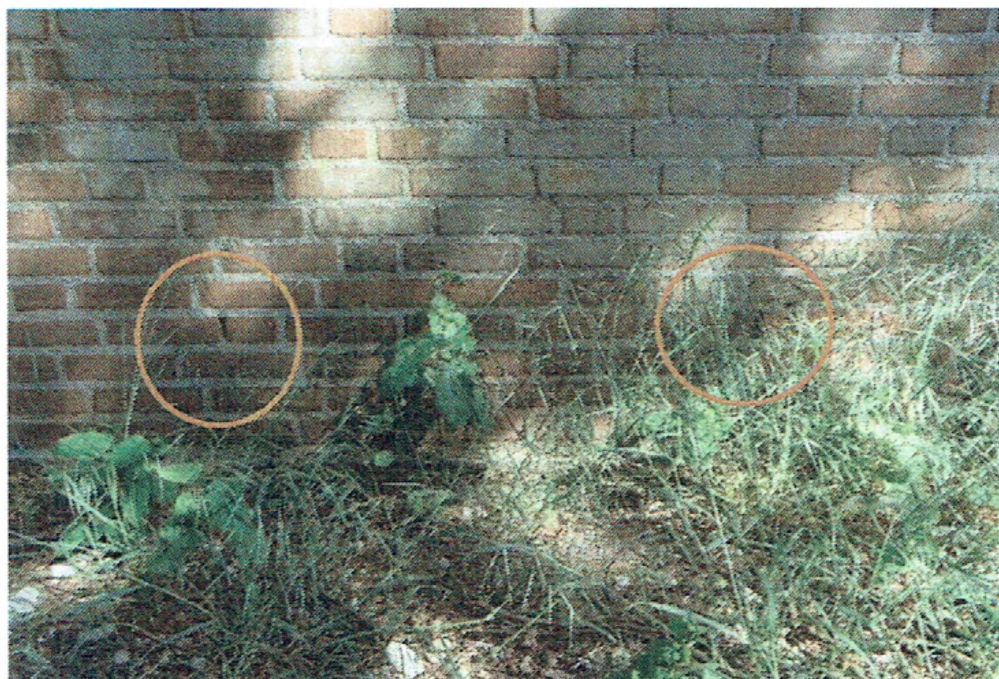
Afbeelding 4 & 5: Spouwmuur is vanaf de bovenzijde dichtgemaakt (4) en aanwezige open stootvoegen (5). Bron: [REDACTED] 13-05-2020
