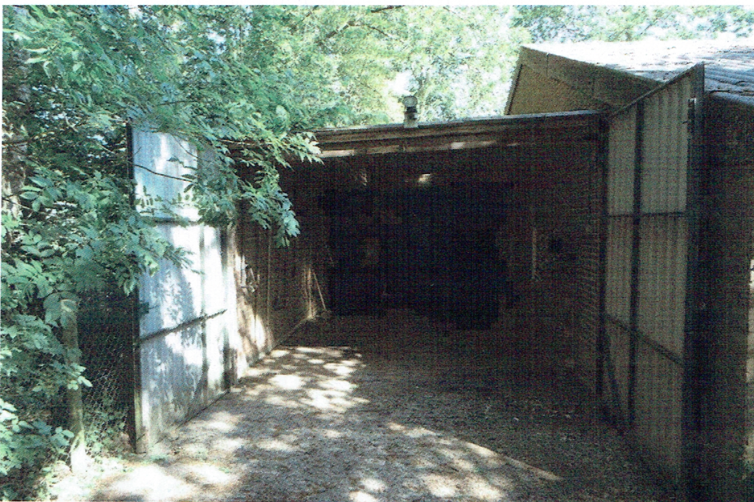
Afbeelding 3: De garage / opslagplaats aan de westzijde van de varkensstal welke ook gesloopt gaat worden. Bron: [REDACTED] 06-05-2020
