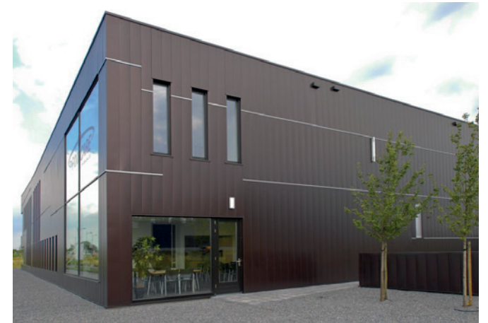
Eén samenhangend geheel (LA Architecten)
