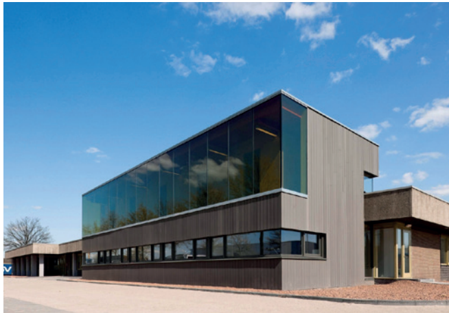
Gerecycled kunststof geveldelen in natureltint (Nexit Architecten)
