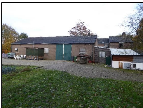
Zuidelijke schuur en opstallen;
