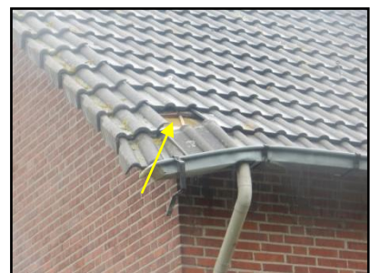
Figuur 16. Losse dakpan die toegang verschaft tot ruimte onder dakpannen.
