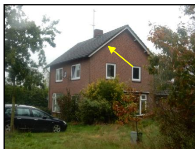
Figuur 15. Overhangende dakpannen geschikt voor gierzwaluw.
