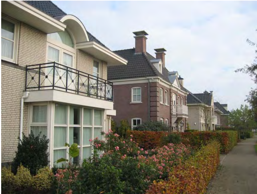
^ recente nieuwbouw Gemeente Gemert-Bakel
