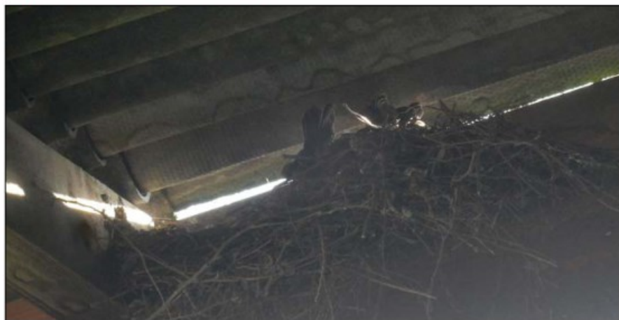
Figuur: onder de overkapping in plangebied B is een merelnest aangetroffen. Eén merel zat op het nest te broeden.
