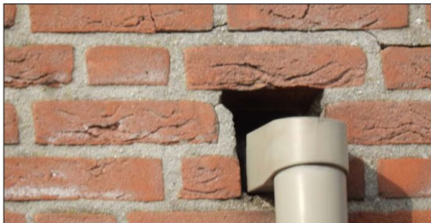
Figuur: er is ruimte bij de regenpijpen in plangebied A waar huismussen kunnen broeden. Ook kunnen vleermuizen in deze opening kruipen en verblijfplaatsen hebben in de spouwmuur.
