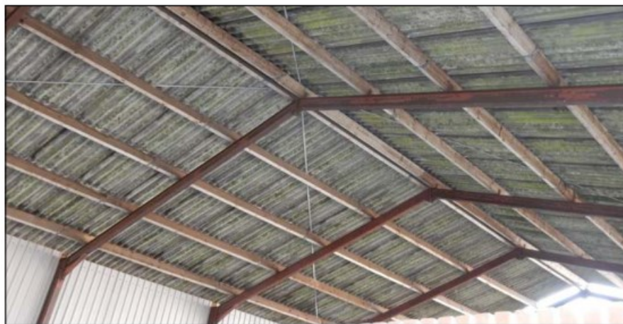
Figuur: de overkapping in plangebied A en B is ongeschikt voor vleermuizen omdat spleetvormige ruimten ontbreken.
