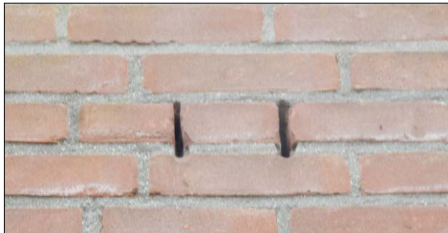
Figuur: in de noordgevel van de garageboxen in plangebied B zijn open stootvoegen aanwezig waar vleermuizen in kunnen kruipen en verblijfplaatsen kunnen hebben in de spouwmuur. Deze openingen zijn te smal voor laatvlieger en drachtige vleermuizen.
