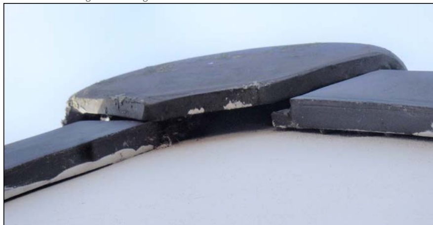
Figuur: een deel van het autobedrijf in plangebied A heeft een pannendak. Onder de nokpan is ruimte aanwezig waar gierzwaluw en huismus kunnen nestelen en vleermuizen verblijfplaatsen kunnen hebben.
