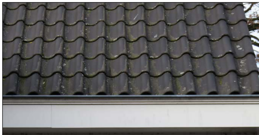
Figuur: huismus kan broeden onder de onderste rij dakpannen van het gebouw in plangebied A.
