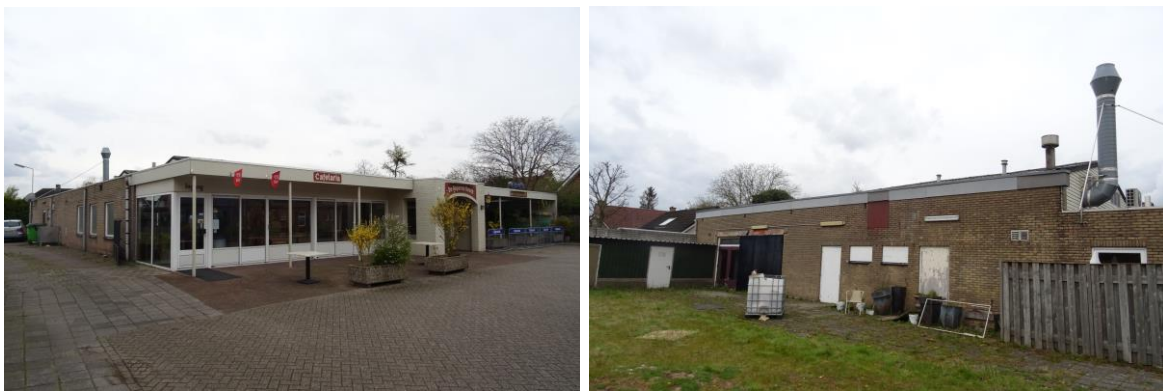
Afbeelding 3 en 4: te slopen bebouwing. Bron: BNL advies. Datum: 08-04-2022
