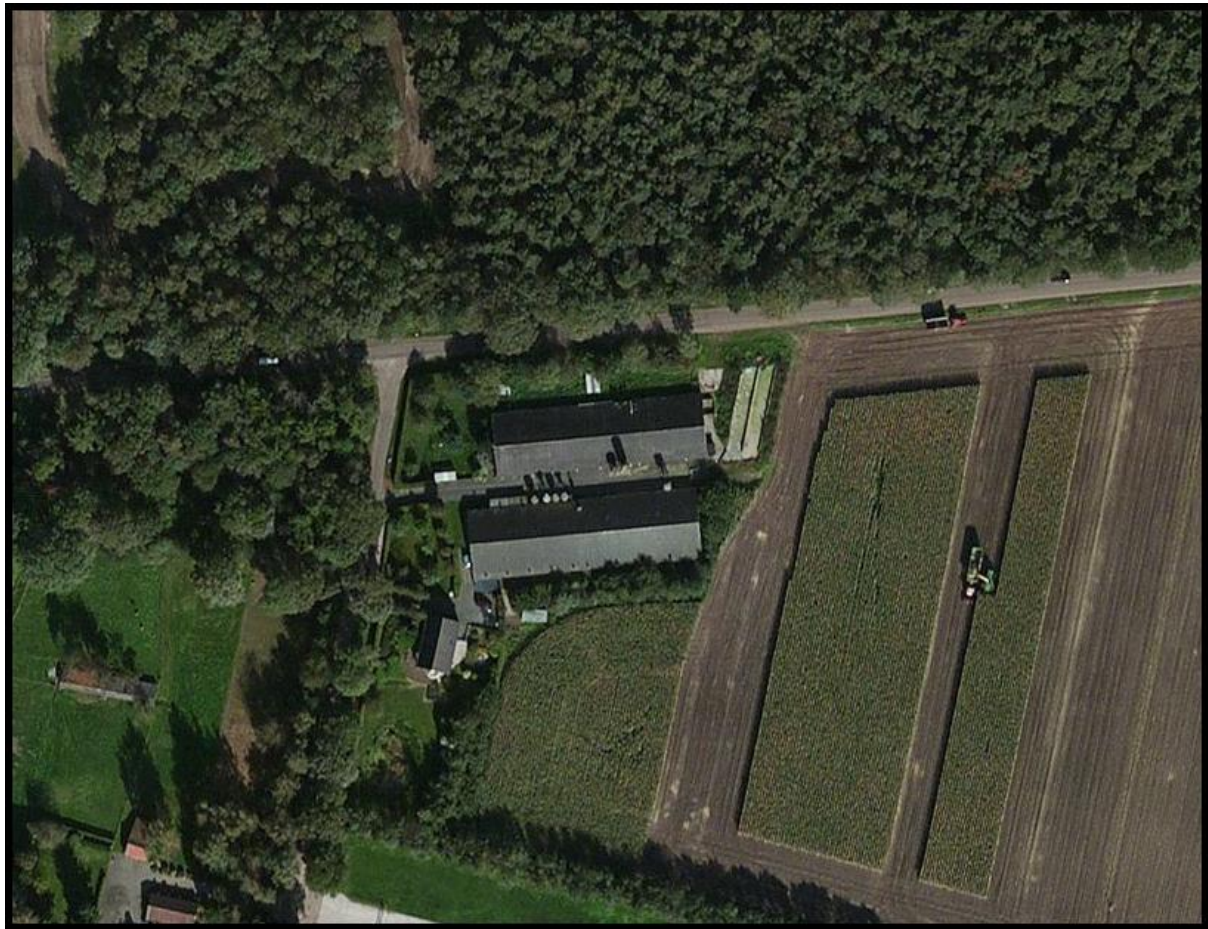
Luchtfoto huidige situatie
