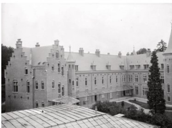
Afb. 34 – Zicht op de binnenkant van de pas gebouwde Jezüitenvleugel, ca 1909
