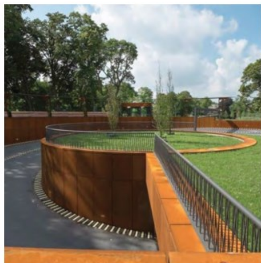
Afb. 68 – referentiebeeld: parkeergarage St.Jan, S'Hertogenbosch
