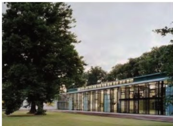
Afb. 70 – referentiebeeld: Oranjerie SAS Nederland, Huizen Architecten)
