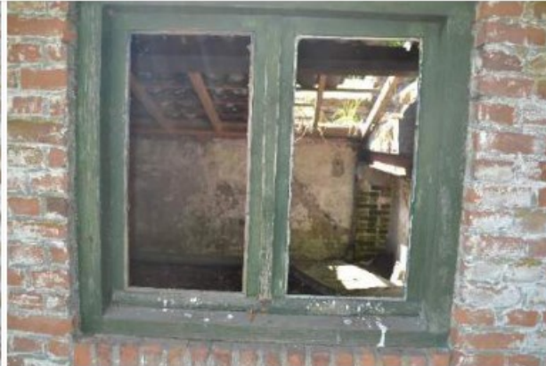
Raamkozijn in gevel van B-02-01
