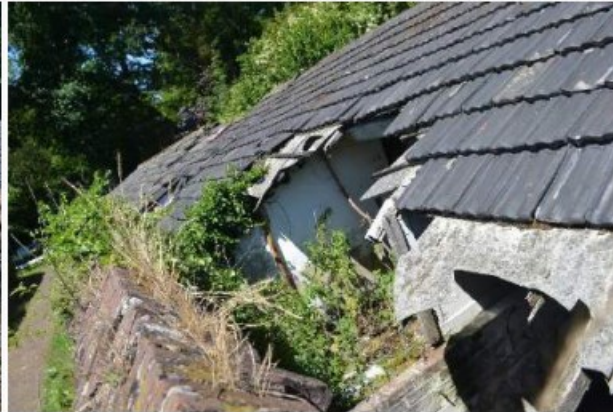
Panbedekking en constructie van dak B-02-01
