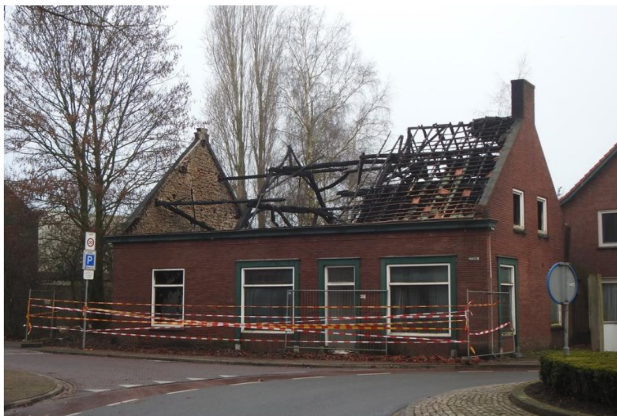
Figuur 2. Deel van het historisch lint, de resterende delen van het afgebrande huis Haageijk 26 zijn op 28 juli 2022 gesloopt. Op de foto is een ouder dakgebinte duidelijk zichtbaar, met links de oude kopgevel.
